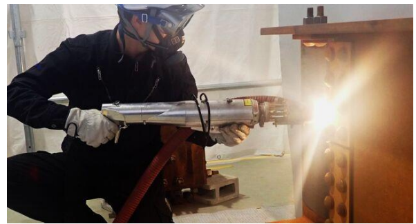
【CoolLaser 施工風景】
