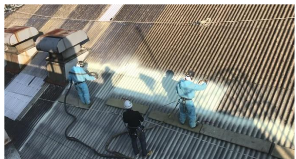
【SOSEI 施工風景】
