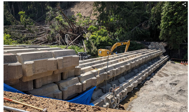
【対策工事の一例（ブロック堰堤）】
